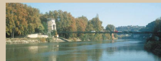
Le pont et le pré de l'île vus depuis l'écluse de Caluire
