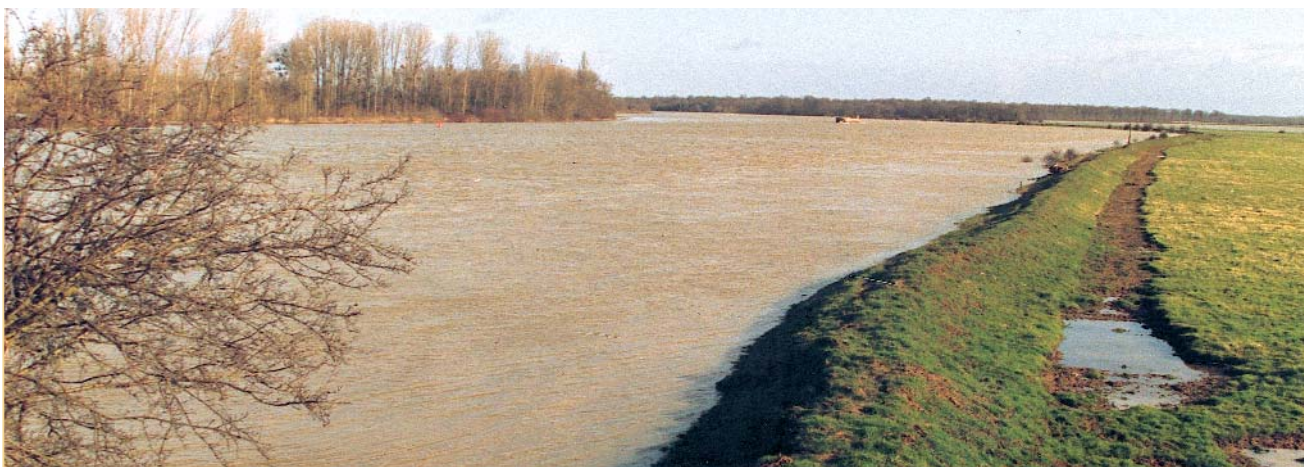
Digue en rive gauche de la Saône
