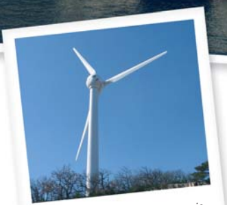
En 2007, 75 porters à connaissance et avis dont 7 avis ZDE et 17 permis de construire éoliens
