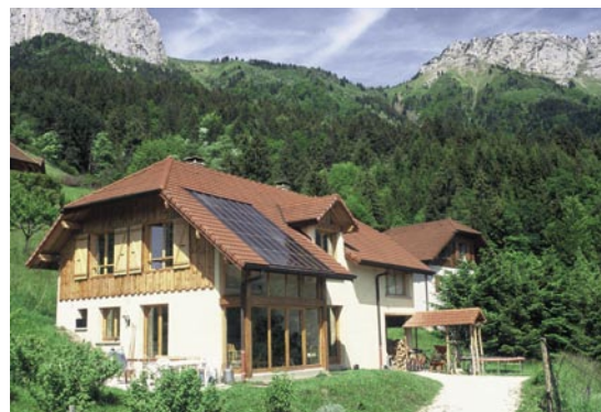
■ Maison équipée de chauffage et d'eau chaude solaire (74)
