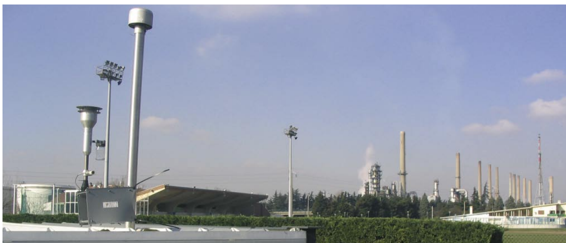
■ Station fixe de surveillance de la qualité de l'air à Feyzin
