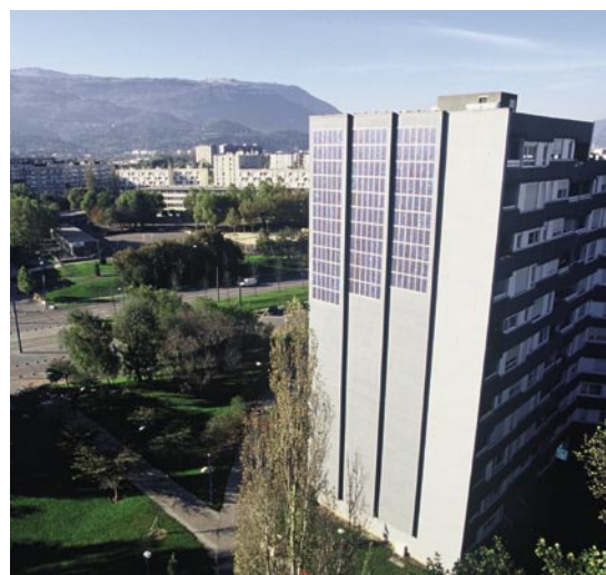
■ Panneaux photovoltaïques sur l'immeuble Surieux à Échirolles (38)
